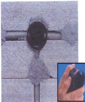
Сл.2.1 Монтажа на инсталациона кутија и инсталациски цевки
